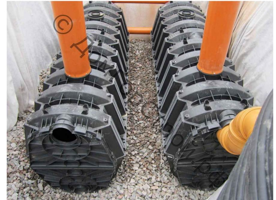
Вентиляционный патрубок DN160 устанавливается сверху тоннеля и служит для воздухообмена.
